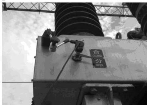
35KV SF6 开关传感器安装
